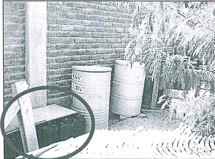
Fotografía N° 4.- Disposición de baterías en desuso junto con materiales para las actividades eléctricas de Enosa. En los círculos se muestran las baterías
