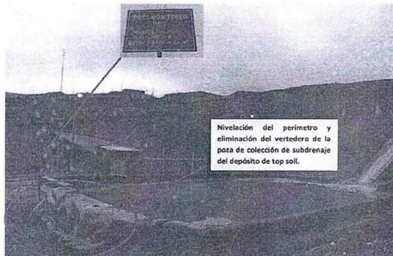
99. De la vista fotográfica se aprecia que el titular minero ya no cuenta con un vertedero en la poza de colección de aguas del subdrenaje del depósito de *top soil* y, a su vez, niveló el perímetro de dicho componente para evitar un posible rebose de aguas en dicha área. Por tal motivo, se concluye que Coimolache ha cumplido con subsanar el hecho materia de la presente imputación.
