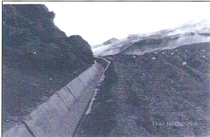
FOTOGRAFÍA N° 14: Canal de coronación del Depósito de Desmonte N° 1. se observa que el canal se encuentra limpio.
