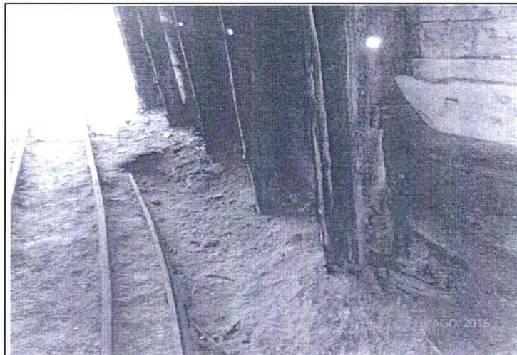
FOTOGRAFÍA N° 2: Salida de bocamina Nv. 4890, sin presencia de agua (Bocamina utilizada para ventilación). Se eliminó el agua empozada.
