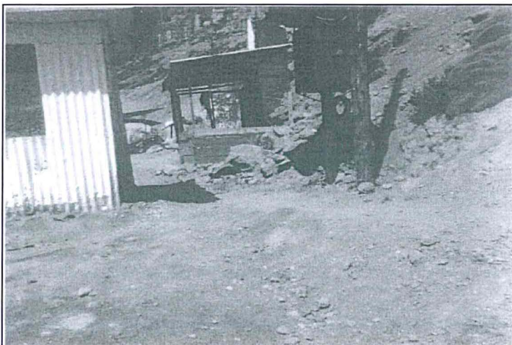
FOTOGRAFÍA N° 8: No existe canalización, por ser agua de no contacto, ni presencia de agua que sale de la bocamina Nv. 4890.
