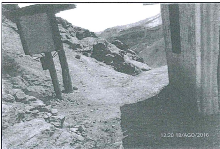
FOTOGRAFÍA N° 7: No existe canalización de agua, por ser agua de no contacto, por ser agua de no contacto.
