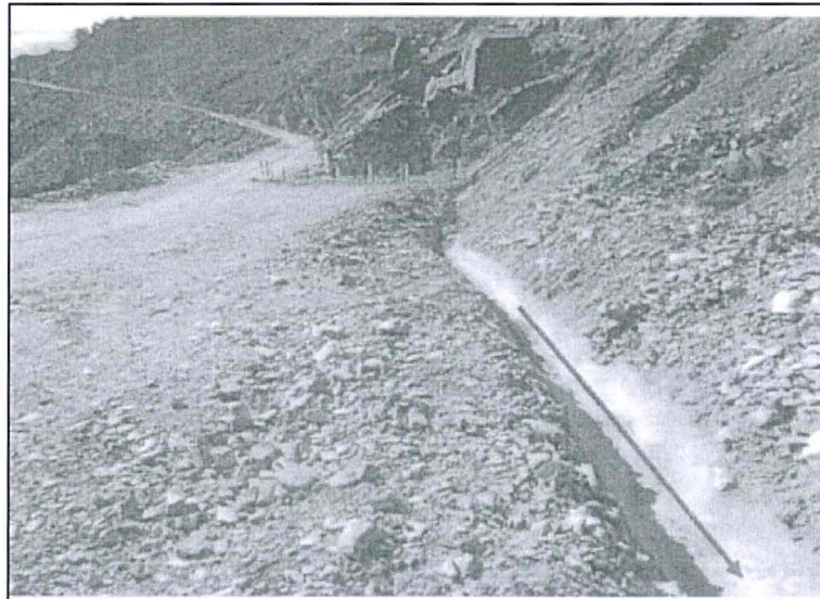
Fotografía N° 5: Cuneta construida en la vía de acceso de la plataforma PLT-23
