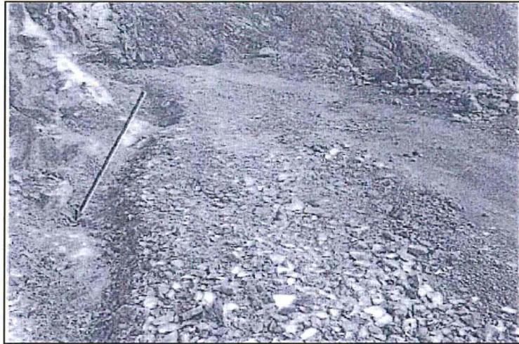
Fotografía N° 7: Cuneta construida en vía de acceso a la plataforma PLT-10
