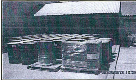
Fotografía N° 1: Vista del almacenamiento de los cilindros conteniendo sustancias químicas (OCTIMISE D3103 y ULTRASOL), obsérvese que el área no cuenta con un sistema de doble contención.
