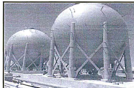
Fotografía N° 9: Vista de la construcción de las dos esferas para el almacenamiento de GLP.
