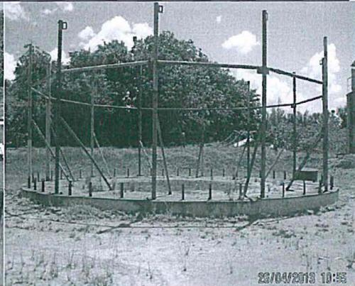
Descripción: Vista de la construcción del tanque (base de concreto y parantes metálica) en la Batería 3 del yacimiento Yanayacu.
