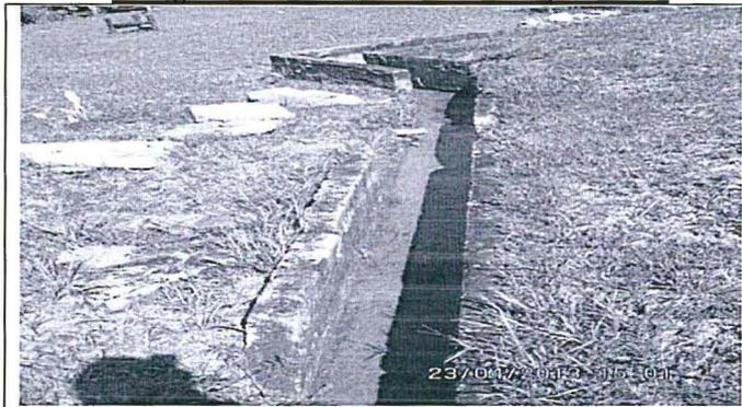
Descripción: Vista del canal perimetral de drenaje deteriorado de la Plataforma 1103 del Yacimiento Pavayacu.
