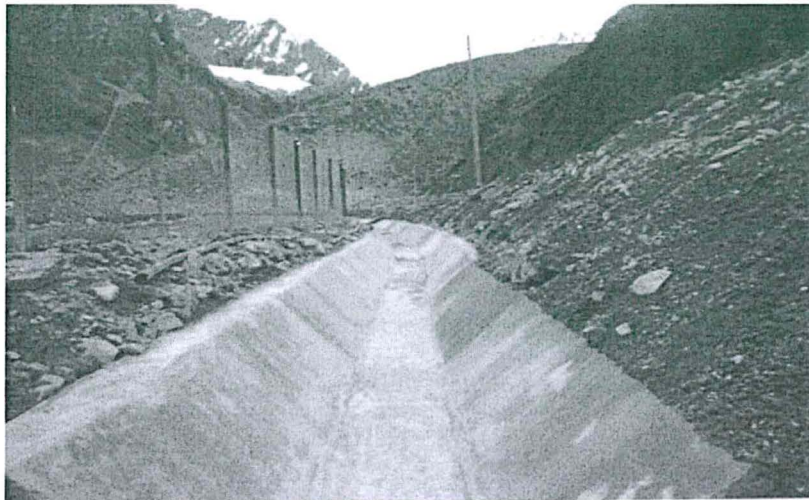
Canal de coronación desmontera El Polvorín
