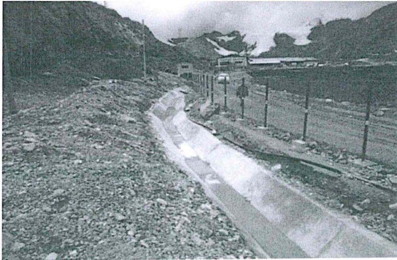
Canal de coronación desmontera El Polvorín
