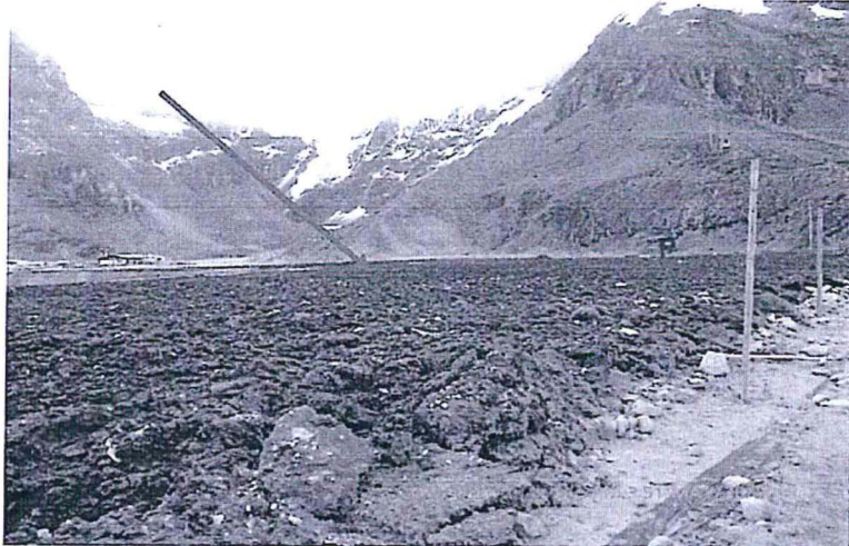
FOTO N° 92: Incumplimiento de Recomendación N° 17, 2011: Parte superior del botadero de desmonte El Polvorín, donde se vienen realizando trabajos de remediación como parte del Plan de Cierre. No cuenta con canales de coronación para las aguas de escorrentía.
