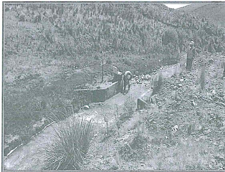
Fotografía N° 115: Punto de monitoreo de efluentes EF-12 Agua clarificada de la cancha de lodos
