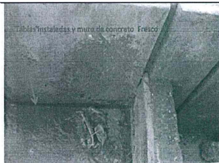
Fotografía N° 7.- Compuerta para la evacuación de aguas clarificadas durante el proceso de asentado y secado de los lodos; se observa las tablas de contención y un muro de cemento recientemente construido (se nota el concreto fresco).
