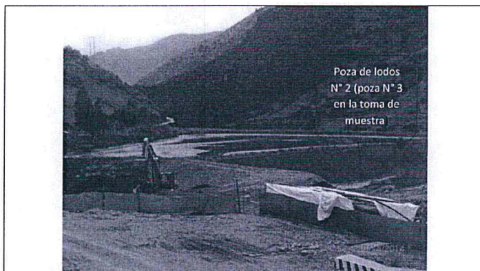
Fotografía N° 16: Vista panorámica de las pozas de lodos N° 2, N° 3 y N° 4, donde se observa trabajos de limpieza y preparación de otra poza para contingencias mediante una retroexcavadora (círculo rojo)
