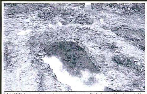
Foto N° 06: Se observa los dos primeros puntos de contención de derrame del crudo, construido para recuperar crudo derramado. No se ha podido recuperar el total del crudo derramado, por la presencia de intensa lluvia en la zona, que rebalsó la capacidad de los dos pozos de contención, que obligó construir otros dos pozos más en la parte baja de la línea de ductos.
