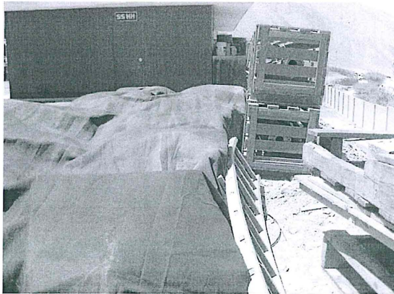
Fotografía N° 71.- Materiales peligrosos (nitrato de plomo) expuestos al ambiente sin una base impermeabilizada en el patio de la planta concentradora.
