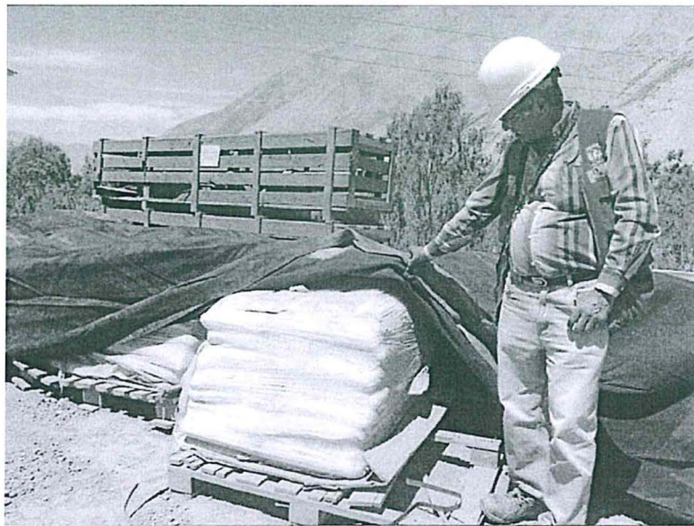
Fotografía N° 72.- Materiales peligrosos (nitrato de plomo) expuestos al ambiente sin una base impermeabilizada en el patio de la planta concentradora.
