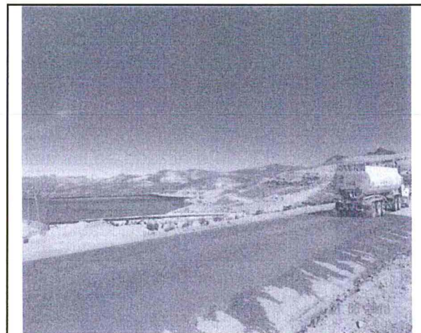
Fotografía N° 2. Riego vía Pallancata - Selene, UTM WGS84 N8376308, E700016
