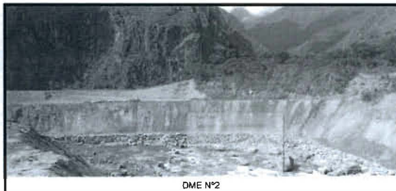
El no llevar a cabo la revegetación evita la consolidación del terreno ocasionando deslizamientos de las riberas del río y la no consolidación de sus taludes.
