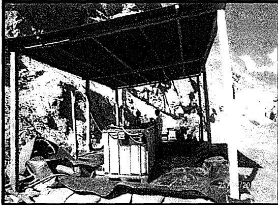
Vista 3. Sistema de almacenamiento de combustible ubicado en la zona de Casa de Máquinas, donde se aprecia las condiciones de almacenamiento de combustible.
