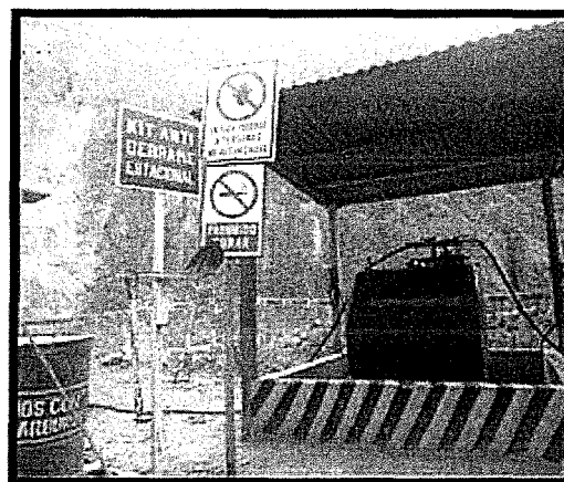
Fotografías 1 y 2 de la Carta CDA/0191-13. Pozas de contención para el almacenamiento de combustible en campo Acceso a Túnel Principal – CASA DE MÁQUINAS
