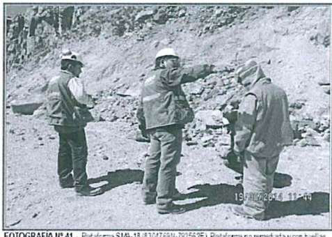
FOTOGRAFÍA N° 41.- Plataforma SMA-18 (8304799N-792562E), Plataforma no remediada y con huellas de erosión de talud.
