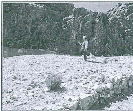
FOTOGRAFIA N° 25.- Plataforma SMA-15 (8304627N-752552E). Plataforma remediada parcialmente falta cobertura de suelos y revegetación, no presenta placa de identificación.
