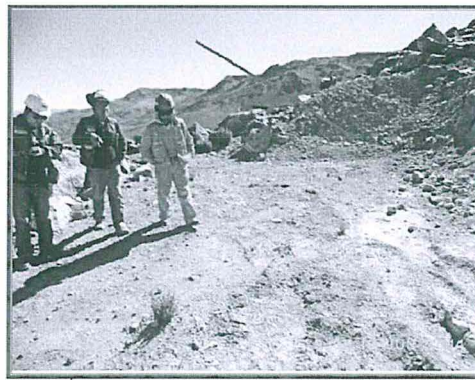
FOTOGRAFIA N° 27.- Plataforma SMA-01 (8304731N-792343E), no cerrada muestra taludes superiores inestables y con procesos de erosión.
