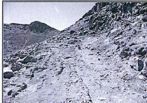
FOTOGRAFIA N° 35.- Plataforma SMA-10 (8304543N-791942E), Plataforma no remediada y con huellas de erosión
