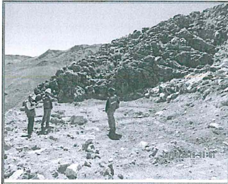
FOTOGRAFÍA N° 38.- Plataforma SMA-05 (8304917N-792202E), Plataforma no remediada y con huellas de erosión.
