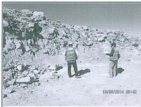
FOTOGRAFIA N° 29.- Plataforma SMA-03 (8304660N-792370E), Plataforma no remediada con taludes inestables.
