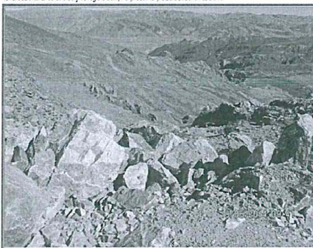
FOTOGRAFIA N° 28. Plataforma SMA-02 (8304687N-792393E) acumulación de materiales en forma inestable sobre el talud de la plataforma.
