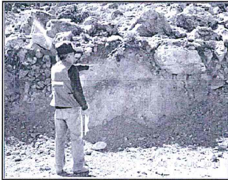
FOTOGRAFIA N° 30.- Plataforma SMA-314 (8304568N-792073E), Plataforma no remediada con taludes inestables
