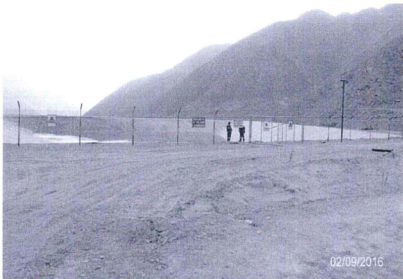
Fotografía N° 66: Vista del depósito de la Poza CIL N° 1, esta poza recibe los relaves cianurados producto del tratamiento del mineral por cianuración, asimismo esta poza se encuentra ubicada dentro del área del Depósito de Relave N° 5.
