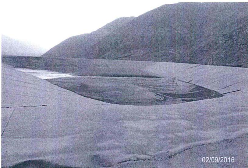
Fotografía N° 67: otra vista de la Poza CIL N° 1, se observa que se encuentra revestida con geomembrana.
