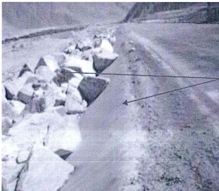
El dique se ha construido con revestimiento de geotextil y enrocado.
