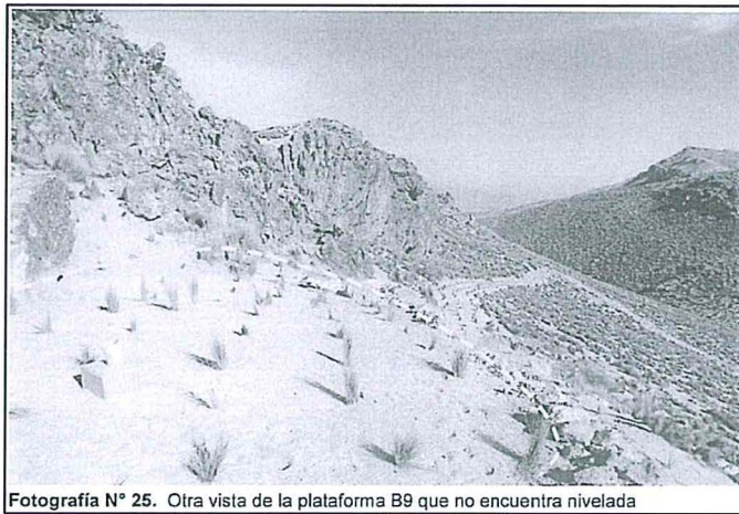
Fotografía N° 25. Otra vista de la plataforma B9 que no encuentra nivelada
