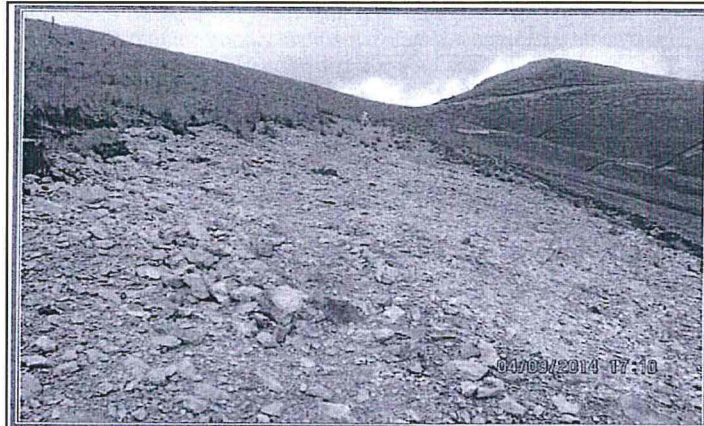
Fotografía N° 5: Hallazgo N° 1. Adyacente al punto de coordenadas UTM WGS 84: 9235352N y 789664E, aproximadamente a 500 m de la plataforma de perforación FE07-04, se constató un acceso al área de exploración, de aproximadamente 10 m de ancho y unos 160 m de longitud, sin revegetación que contrasta con el entorno.
