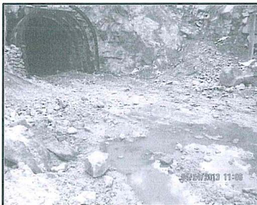
Fotografía N° 32: El efluente minero proveniente de la Bocamina Nivel 660 descarga en tal cantidad que forma charcos en el cuerpo receptor suelo.
