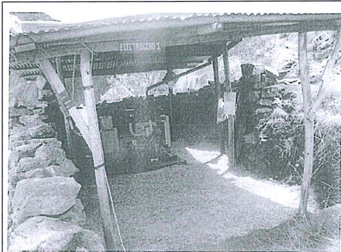
Fecha de toma: 07/01/2017 Coordenadas UTM WGS84 17 S: 780569 E, 9154698 N
