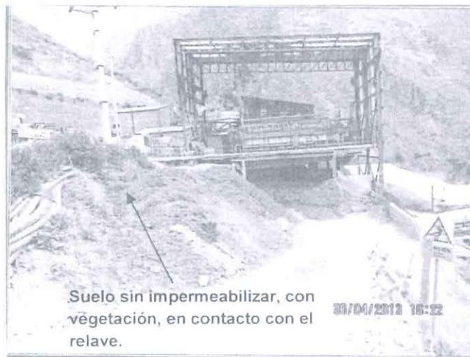
Fotografía N° 117: Hallazgo 17 Planta de Filtrado y Patio de Relaves. No se encontraba en funcionamiento por paralización de la planta de beneficio. Frente al patio de relaves, se constató la disposición de relave fresco sobre suelo natural, sin impermeabilización.
