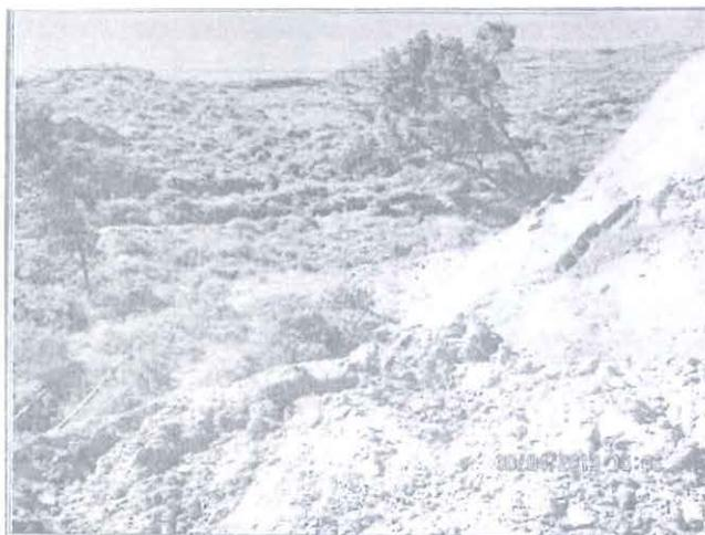
Fotografía N° 84: Hallazgo N° 8 Depósito de Relaves N° 1 y 2. En la parte alta, lado Norte del Depósito de Relaves N° 1 y 2, Una mezcla de materia con relave está en contacto directo con el suelo natural, no existe impermeabilización
