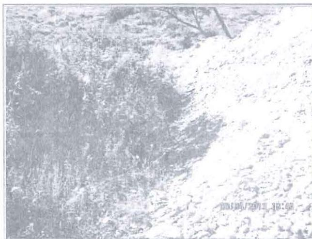
Fotografía N° 85: Hallazgo N° 8 Depósito de Relaves N° 1 y 2. En la parte alta, lado Norte del Depósito de Relaves N° 1 y 2, Una mezcla de material con relave está en contacto directo con el suelo natural, no existe impermeabilización
