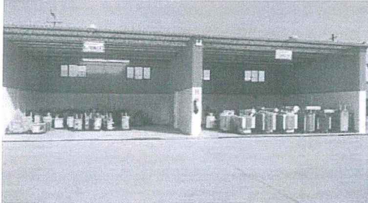
Almacén Residuos peligrosos (transformadores) CO piso cemento pulido terminado 2013
