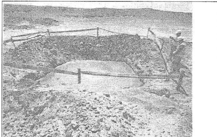
Foto N° 47.- Poza de lodos PH-275, Coordenadas UTM WGS 84 N; 8 323 783; E: 493 475, en proceso de cierre.
