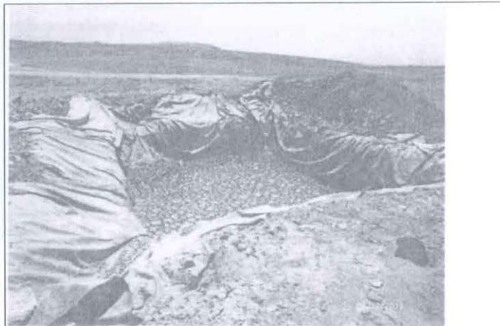
Foto N° 51 - Poza de lodos PH-311. Coordenadas UTM WGS 84 N: 8 323 618; E: 493 463, en proceso de cierre.
