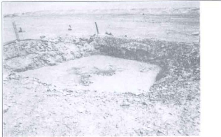
Foto N° 48. Poza de lodos PH-282, Coordenadas UTM WGS 84 N: 8 323 727; E: 493 370, en proceso de cierre.
