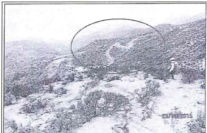
Fotografía N° 62.- Acceso a la plataforma de perforación con código de sondaje BDC-23, se observó presencia de cárcavas. Falta perfilar y revegetar.
