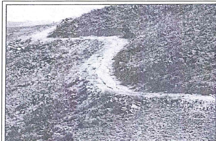
Fotografía N° 38.- Acceso a la plataforma de perforación con código de sondaje BDC-22, en el cual se observó presencia de cárcavas. Falta perfilar y revegetar.
