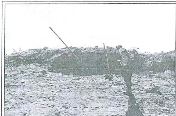
Fotografía N° 1.- La plataforma de perforación presentaba corte del terreno, remoción de suelo y rocas sueltas; asimismo, se verificó un sondaje con código BDC-02, que presentaba un bloque de concreto con una tubería de PVC. Falta perfilar y revegetar (Coordenadas UTM Datum geodésico WGS84: 9 095 366N 764 788E).
