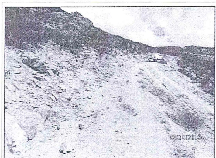
Fotografía N° 42.- Acceso a la plataforma de perforación con código de sondaje BDC-11, en el cual se observó rocas sueltas. Falta perfilar y revegetar.
