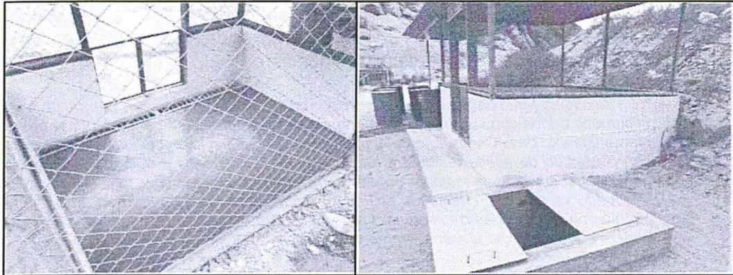
22. De acuerdo a las pruebas antes señaladas, Yanapampa implemento un almacén de residuos sólidos temporal que se encuentra techado, cercado y cuenta además con piso liso, impermeabilizado y un drenaje para el control de lixiviados; de ello se acredita que **Yanapampa corrigió la conducta infractora antes del inicio del presente procedimiento administrativo sancionador** (19 de octubre del 2016).
