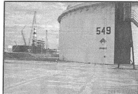
FOTO XIV: Tanque NL 549, muro y piso impermeabilizado.
