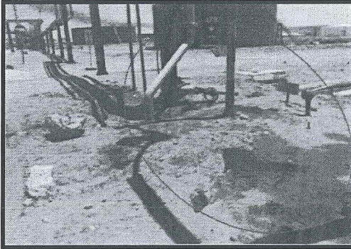
Foto N° 115: N 9493340, E 468576 En la fotografía se observa, suelo impregnado con hidrocarburos, ubicado al costado de válvula del rack de tuberías, al lado norte del área estancia del tanque N° 300. Área 6.00 x 5.00 mt.
