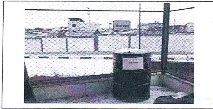
Descripción: Vista del cilindro rotulado, que contenía borra, dispuesto en el área de almacenamiento de residuos peligrosos de la Planta de Ventas Iquitos.
