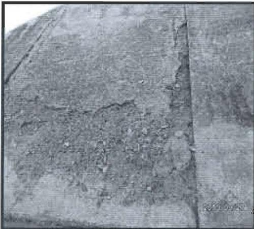
Fotografía N° 9: Vista de uno de los paños de concreto del dique de protección del tanque en proceso de deterioro por erosión
