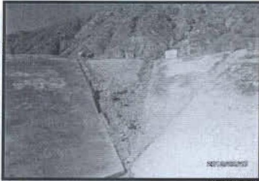
Fotografía N° 11: Otra vista de dique del área estanca, donde la erosión genero deterioro
