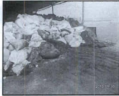
Fotografía N° 16: Se observa tierra contaminada se desparrama al suelo por el lado sin protección del almacén de residuos peligrosos.
