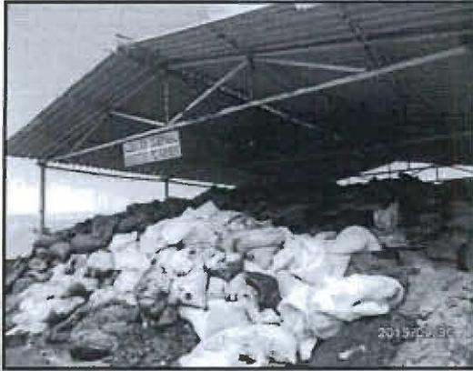
Fotografía N° 15: Vista del almacén de residuos peligrosos Bayóvar con sacos de tierra contaminada con hidrocarburos rebasando su capacidad.
