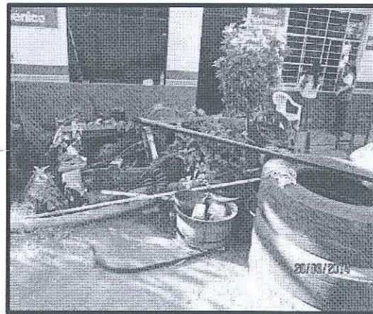
Fotografía N° 5: Vista del acopio de residuos sólidos peligrosos y no peligrosos en un suelo no impermeabilizado al costado de la zona de almacenamiento de CL.
