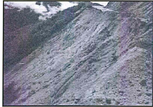
Fotografía N° 27. Tramo i+7: Material excedente lanzado hacia la quebrada eliminando la vegetación natural
