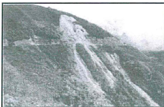
Fotografía N° 19. Tramo i+2: Talud inestable con pendiente mayor a 2:1 sin medida de estabilización
