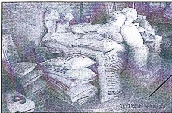
Descripción: Vista interior del Almacén de Sustancias Químicas, se observa que el piso no se encuentra impermeabilizado.
