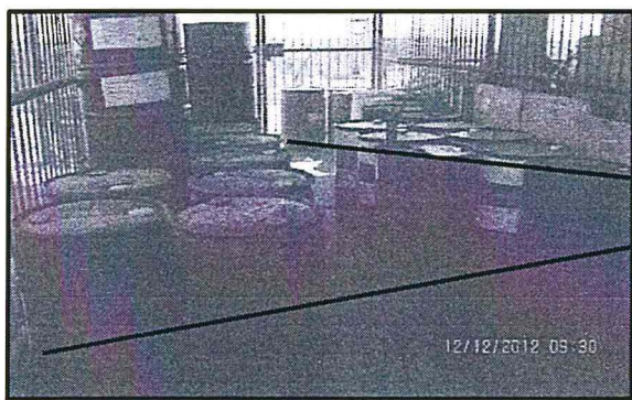
Descripción: Vista interior del área de almacenamiento de lubricantes, se observa que no cuenta con un sistema de doble contención.
