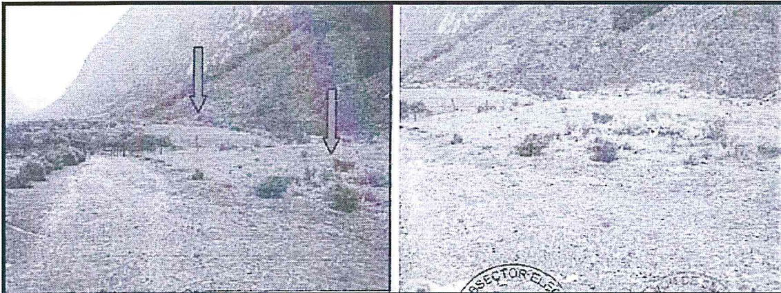
Fotografía N° 13. Zonas deforestadas frente a la presa y al lado de la caseta de control. Fotografía N° 14. Zona sin plántones al lado de la caseta de control.
