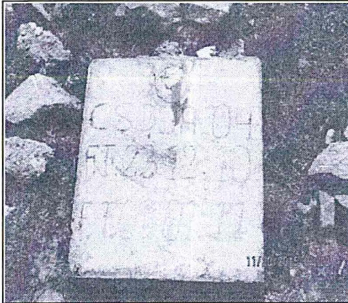
A. Plataforma cerrada y obturada con base de cemento
