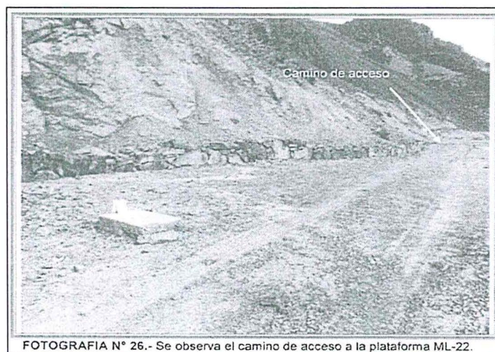
FOTOGRAFIA N° 26.- Se observa el camino de acceso a la plataforma ML-22.
