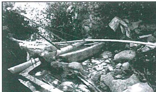
Fotografía 6. Bocatoma de la piscigranja. Muestra tubería de 5" que ingresa agua limpia a la piscigranja del río Ocos – Mayura. Línea naranja señalada charco empozando con hidrocarburos y conduce agua contaminada a los cilindros de almacenamiento.
