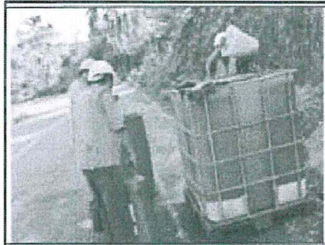
Foto N° 09: Personal vaciando aguas contaminadas con combustibles en boom drum.
