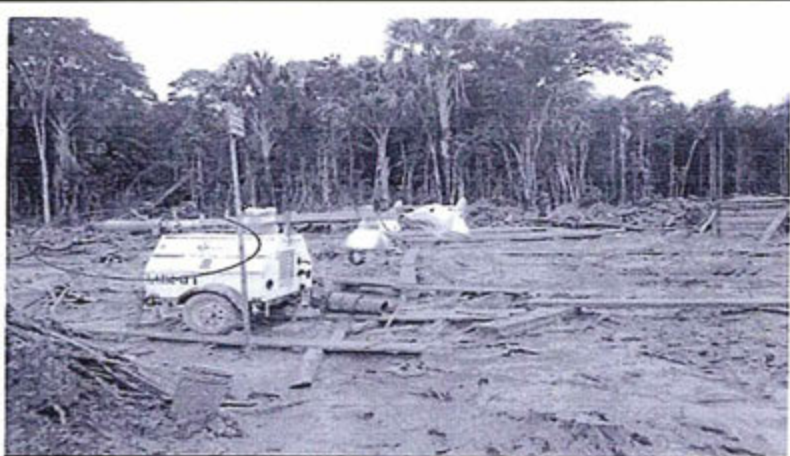
Foto N° 04: Se observa un área impactada aprox. 600 m 2 , por el derrame de recortes y lodos de perforación. El área impactada por naturaleza es una zona inundable, actualmente está cubierta de materiales de derrame. Por otro lado, se puede observar, que el derrame fue controlado, cercado y contenido con barreras de geomembrana de color negro.
