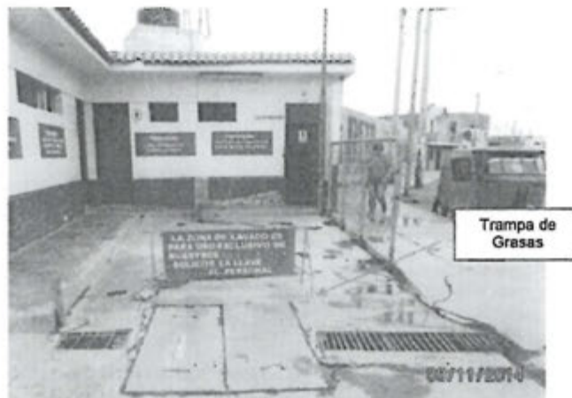
Fotografía N° 07.- Vista del Área de lavado y trampa de grasas, del Puesto de Venta de Combustible - Grifos, de la empresa GRIFOS ELEUTERIO MEZA G S.A. Localización UTM (WGS84) N: 8 772 248 y E: 0 216 497
