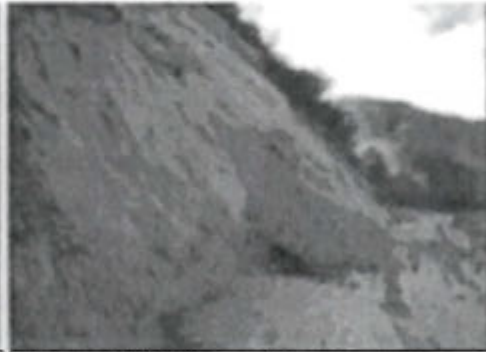
Fotografía N° 16. Tramo i+1: Talud inestable con pendiente mayor a 2:1 sin medida de estabilización
