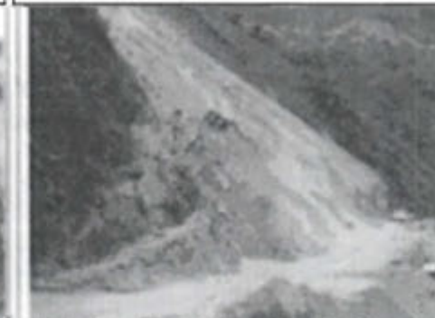
Fotografía N° 25. Tramo i+4 Talud inestable con pendiente mayor a 2:1 sin medida de estabilización
