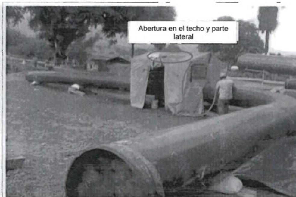
Fotografía 06. Abertura en el techo y parte lateral en carpa donde se realiza la tarea de granallado
