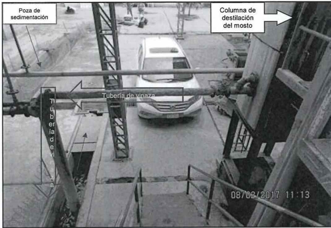
Foto N° 1: Circuito de conducción de la vinaza que se genera en la fabricación de alcohol en la planta de destilería Naylamp del administrado, que son direccionadas a la poza de sedimentación para su posterior descarga al Dren 4000. (vista de sur a norte).
