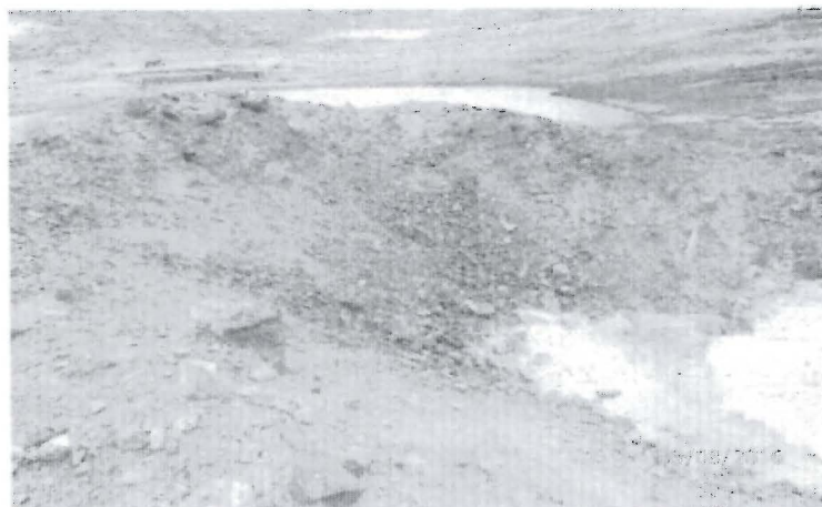
Fotografía N° 57: Vista lateral del botadero de desmonte L1 D47-SD. Se observó desmonte dispuesto en el área.
