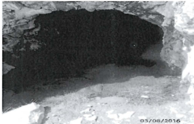
Fotografía N° 4: Vista de la bocamina L1-B30-D. Se observó presencia de drenaje.
