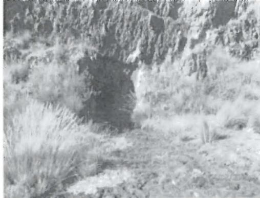
Fotografía N° 6: Vista de la bocamina L2-B22-T. Se observó que no se han realizado actividades de cierre. Presencia de drenaje proveniente de la bocamina que entra en contacto con un bofedal adyacente.
