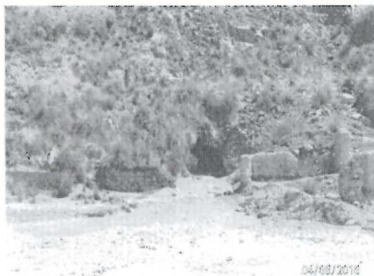
Fotografía N° 34: Vista panorámica de la bocamina L2-B25-CL ubicada en las coordenadas UTM WGS-84 N: 8918546, E: 227287. Se observó que no se han realizado actividades de cierre. Presencia de drenaje proveniente de la bocamina.
