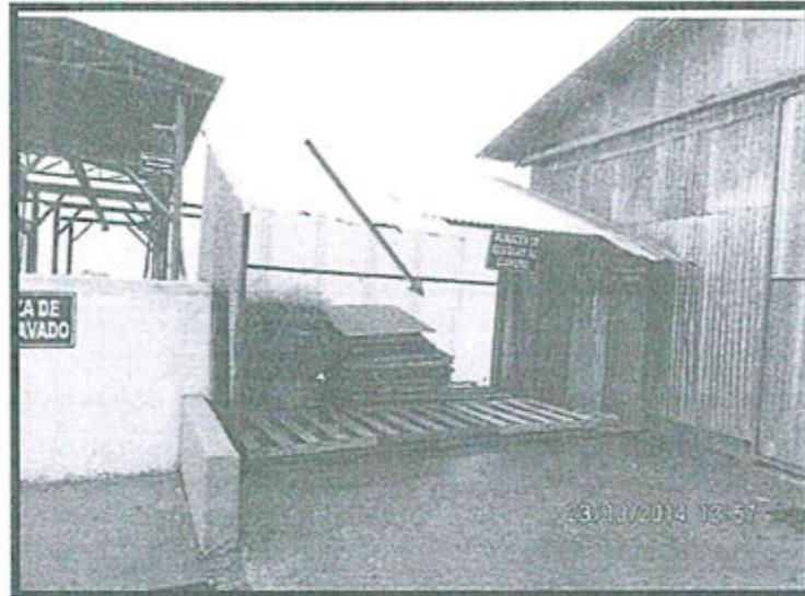
**Fotografía N° 136 del Informe de Supervisión:** Hallazgo N° 8, Supervisión 2014: En el almacén de acopio de residuos de cianuro (residuo peligroso) de la Planta Merrill Crowe, se observa que no se encuentra completamente cerrada.
