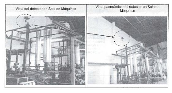
28. Al respecto, dado que la obligación establecida en la medida correctiva es respecto a la instalación de un detector de fuga de refrigerantes en la planta de congelado y habiéndose acreditado que el administrado realizó la instalación de dos detectores de fuga de refrigerante, queda acreditado el cumplimiento de la medida correctiva.
