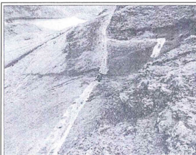
Foto n° 05: Control de escorrentía para control de erosión.
