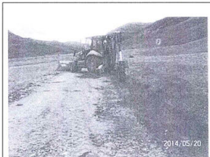
Foto N° 01: Habilitado de cunetas en los accesos
