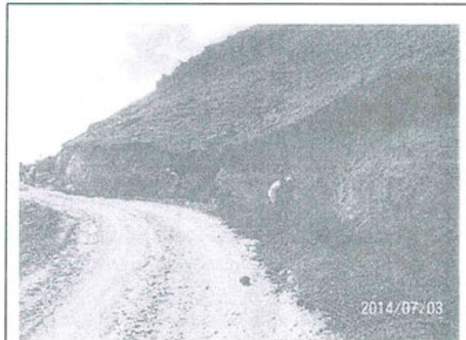
Foto N° 04: Mantenimiento de cunetas en acceso principales
