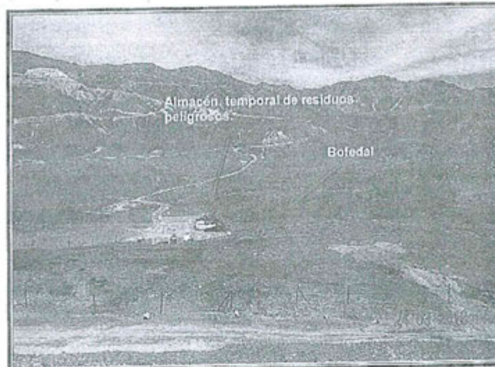
Fotografía N° 16: Hallazgo 9, vista panorámica del área donde se encuentran ubicados en el almacén temporal de residuos peligrosos y almacén de materiales y equipos de trabajo, se encuentra a un metro de un bofedal.
