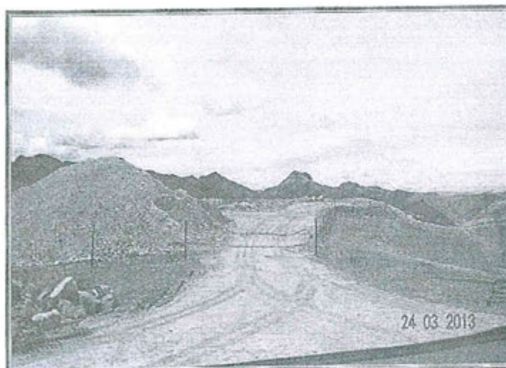
Fotografía N° 27: Vista fotográfica del material de corte, sin infraestructuras hidráulicas.
