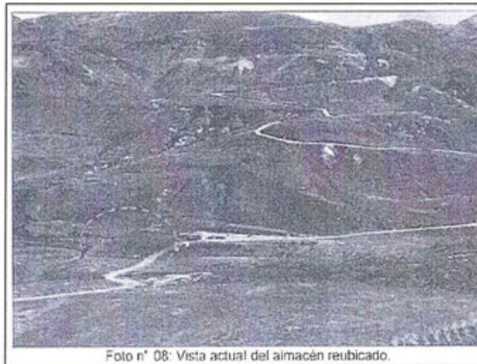
Foto n° 08: Vista actual del almacén reubicado.
