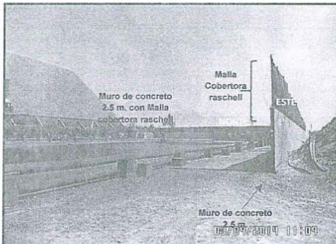
Fotografía N° 42 del Informe de Supervisión: Vista de muro de concreto con malla de contención en el lado Norte y Este de la poza de efluentes, no cuenta con malla cobertora. Consignado en el Hallazgo N° 1. Ubicado en las coordenadas UTM WGS 84: N 8 882 071, E 809 307.
