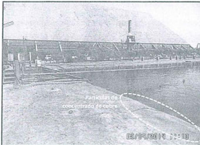
Fotografía N° 41 del Informe de Supervisión: Vista de la poza de efluentes, se observan acumulación de partículas de concentrado de cobre sobre la geomembrana. La poza no cuenta con malla cobertora. Consignado en el Hallazgo N° 1. Ubicado en las coordenadas UTM WGS 84: N 8 882 071, E 809 307.
