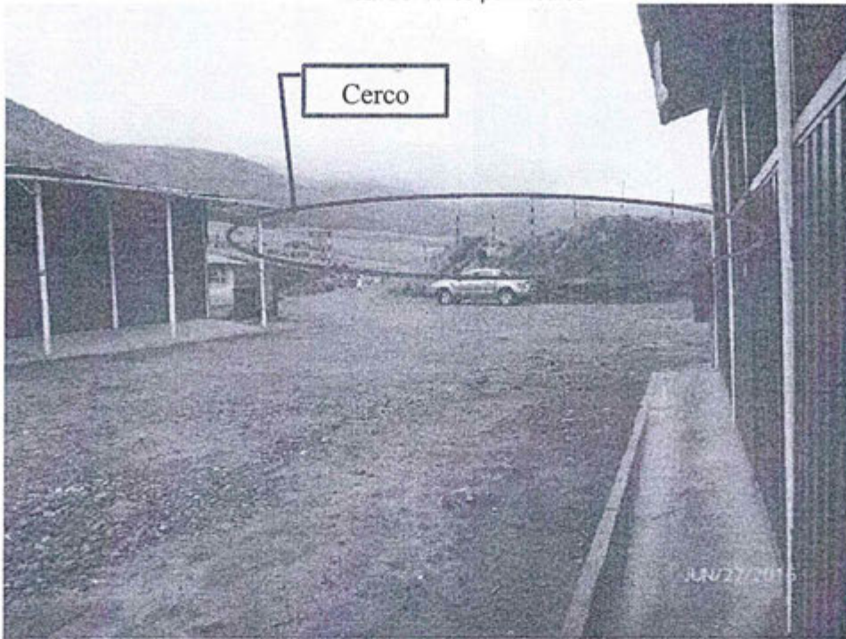
Vista del cerco perimétrico
