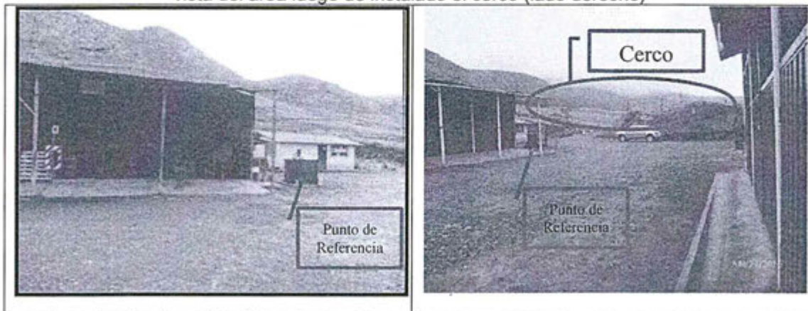
Vista durante la Supervisión (lado izquierdo) y vista del área luego de instalado el cerco (lado derecho)
