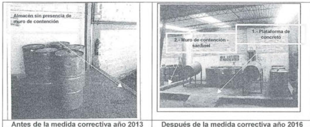
42. Sumado a ello, conforme se observa de la Fotografía N° 2, VJ Gas implementó un muro de contención de tipo sardinela y la plataforma de concreto, que impermeabiliza el suelo del almacén, en las coordenadas UTM WGS 84 de referencia Norte 8 417 786 y Este 261 263, las cuales acreditan que las acciones implementadas se realizaron dentro de la unidad productiva.
