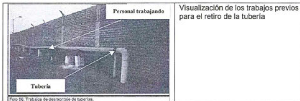
Foto 06: Trabajos de desmontaje de tuberías.
